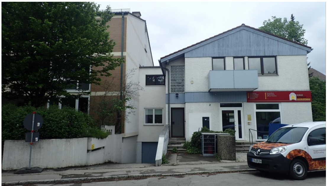
Abb. 3: Blick von Kreuzung auf geplantes aufzustockendes Gebäude mit angrenzender Nachbarbebauung Quelle: Aufnahme PV München
